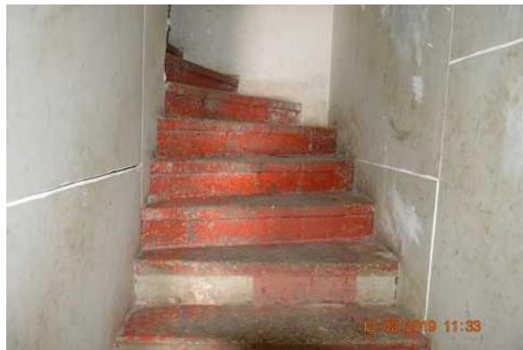
14. schodiště do 2.NP.
